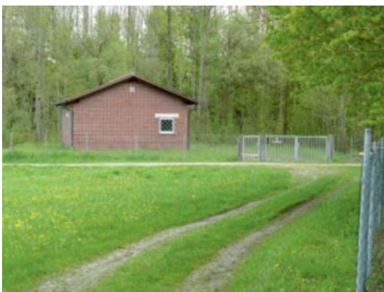
altes Pumphaus Osterholzen, Schutzzone I
