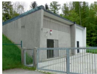
HB Bad Griesbach Fassungsvermögen 1.500 m 3
