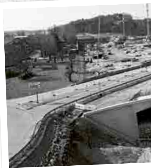
Bauarbeiten für den Tunnel Tutting: Das Bauwerk
