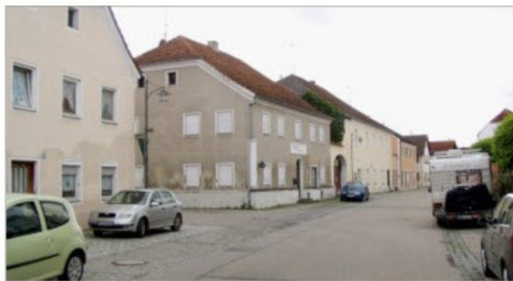
Zwei große Gebäudekomplexe mitten im Ortszentrum sind leer.
