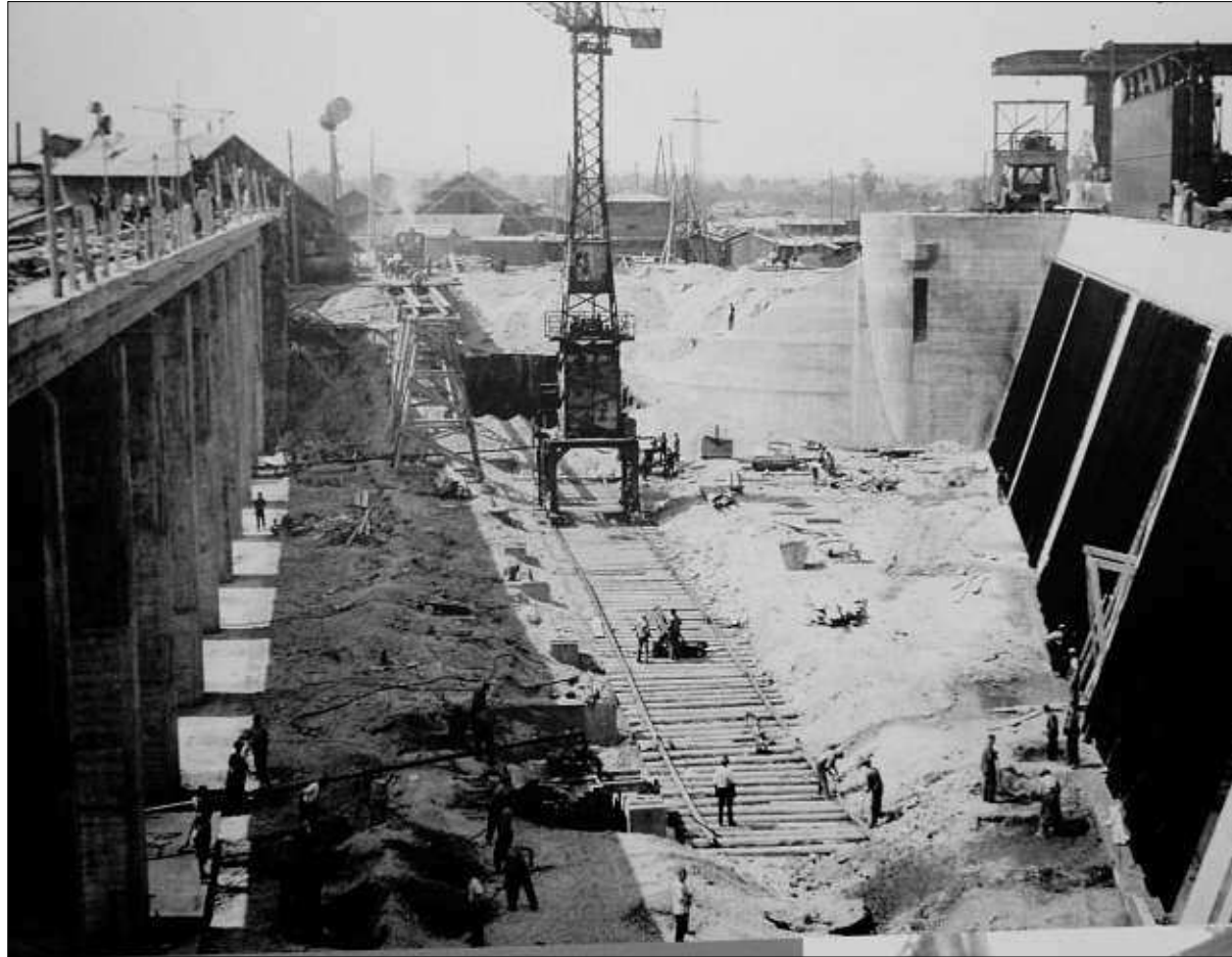
Die historische Aufnahme vom 9. Februar 1943 zeigt die Baugrube der Eglfingener Kraftwerks zwischen Vorrechen und Krafthaus.
