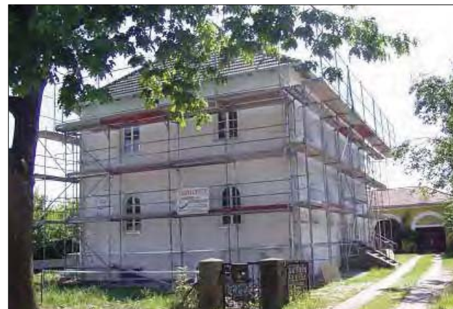
Das einstige königliche Zollamt in Eggfling an der Alten Innstraße. Das Gebäude ist noch Zeuge einer längst vergangenen Zeit.
