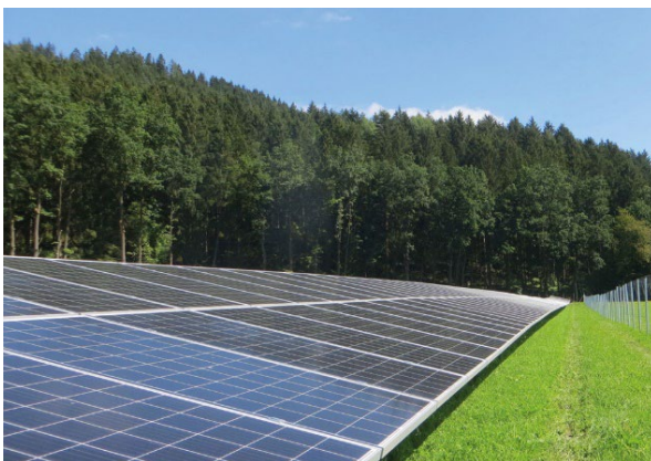
Freiflächen-PV-Anlage vor Waldkulisse
