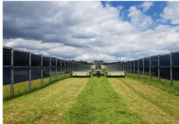
Freiflächen-PV-Anlage, Module senkrecht
