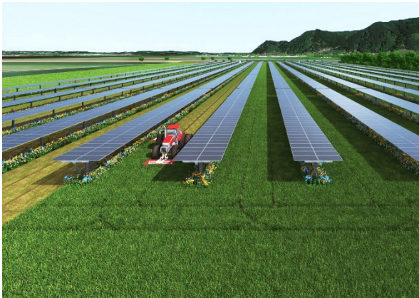
Freiflächen-PV-Anlage in Bewirtschaftung integriert, waagrecht
