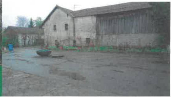
Abbruch, Erweiterung Hotelbereich
