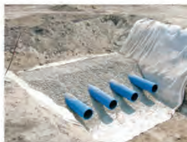
Vliesbahnen, provisorisch an den Grabenrändern befestigt
