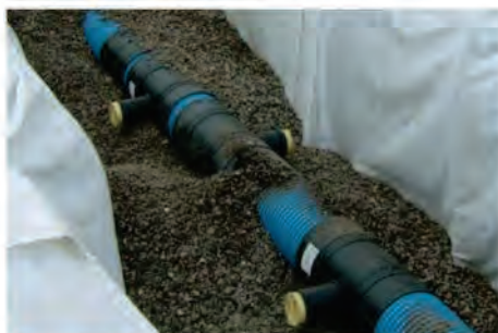
Leitungszone mit Rigolenkies verfüllen
