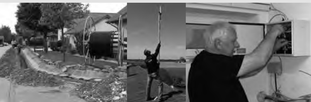
Mitte: Ein Techniker richtet die Funkantenne auf dem Dach des Bürgerhauses in Würding ein.
