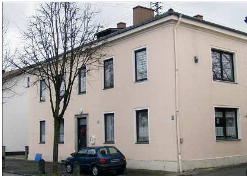
Über 100 Jahre war die Gemeindekanzlei in der „Alten Schule“ (erbaut um 1830) untergebracht. – Fotos: Diet
