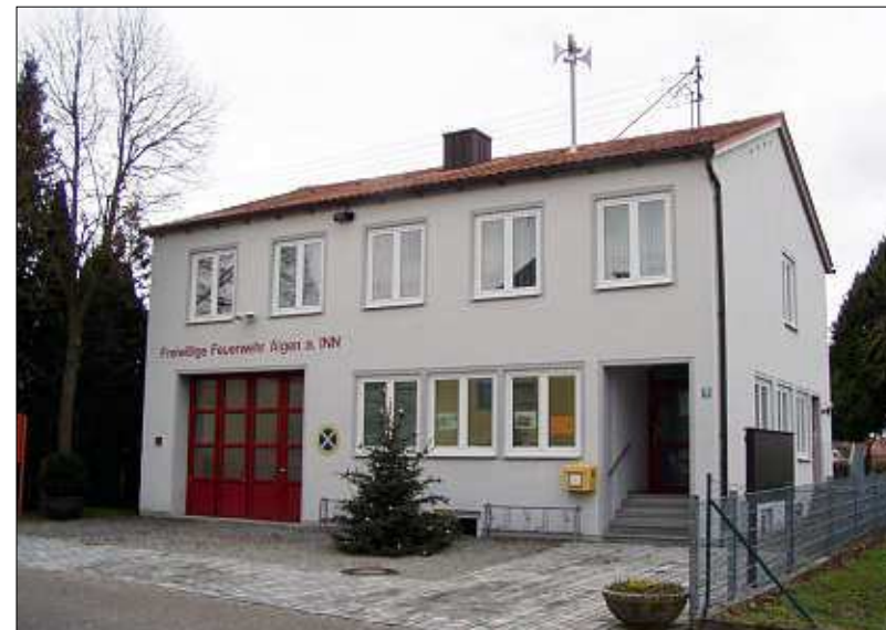
Die Aigener forderten die Weiterführung der Amtsstunden in der Gemeindekanzlei am Ort im 1964 gebauten Rathaus mit Feuerwehrhaus.
