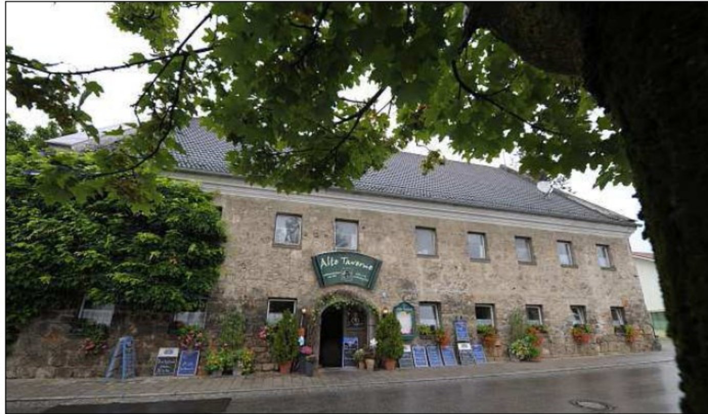
So sieht das Gasthaus Fuchs in Würding heutzutage aus.
