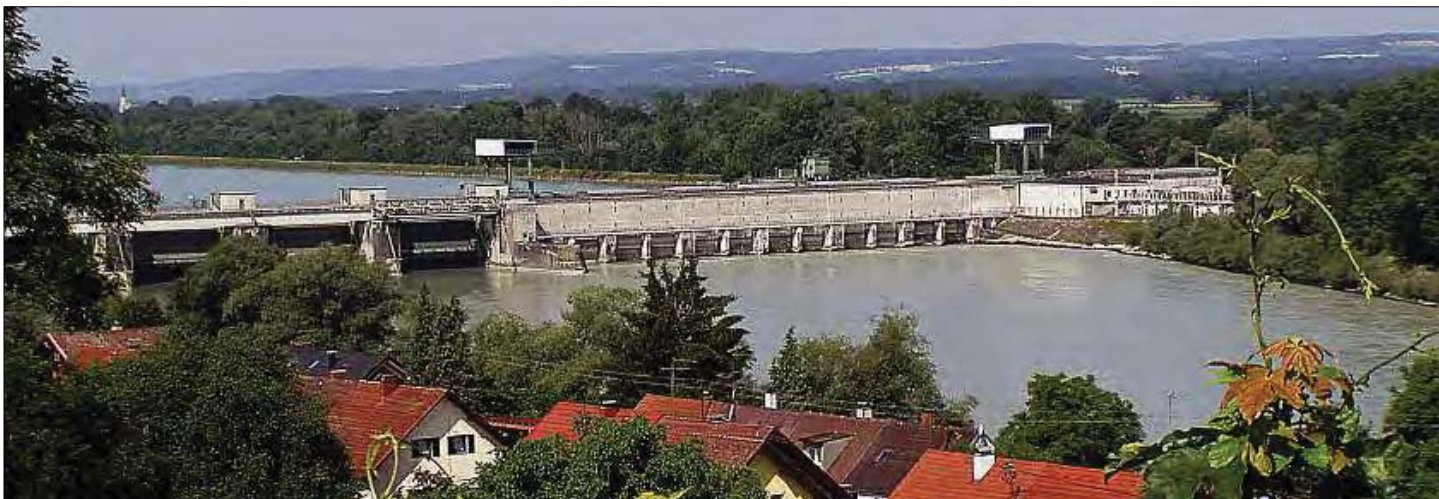
20 Jahre lang – in der Zeit von 1945 bis 1965 – diente das Innkraftwerk Egglfing-Obernberg vor allem für Fußgänger, Rad- und Motorradfahrer als Übergang über den Inn. – Fotos: Diet
